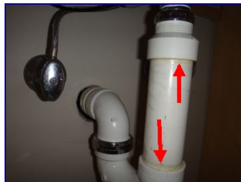
Primer not visible. PVC pipe connections.
